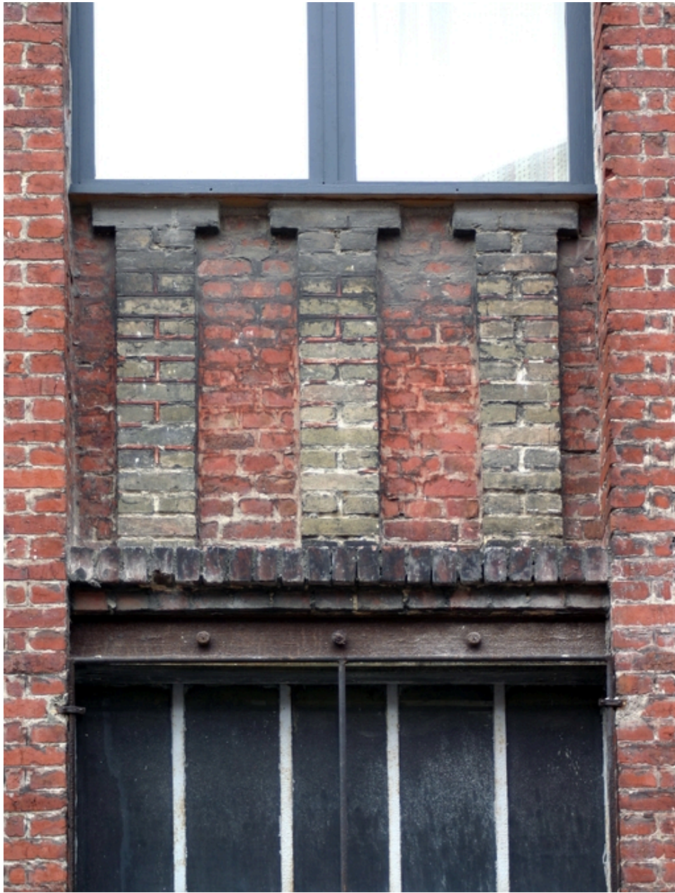
Façade antérieure : traitement des allèges des baies du premier étage.
