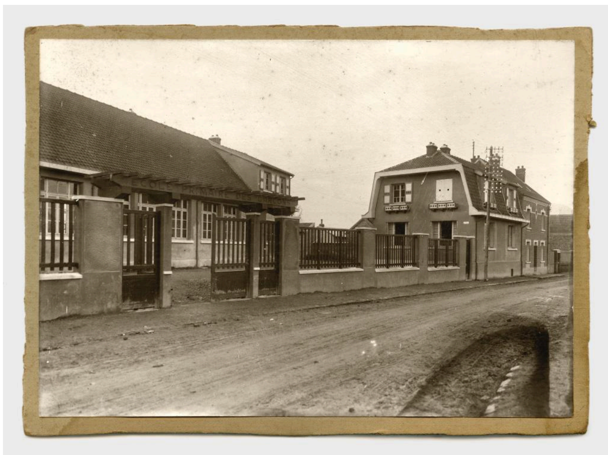
Villers-Bretonneux. L'école Victoria. Photographie, vers 1930 (coll. part. Drillancourt).
