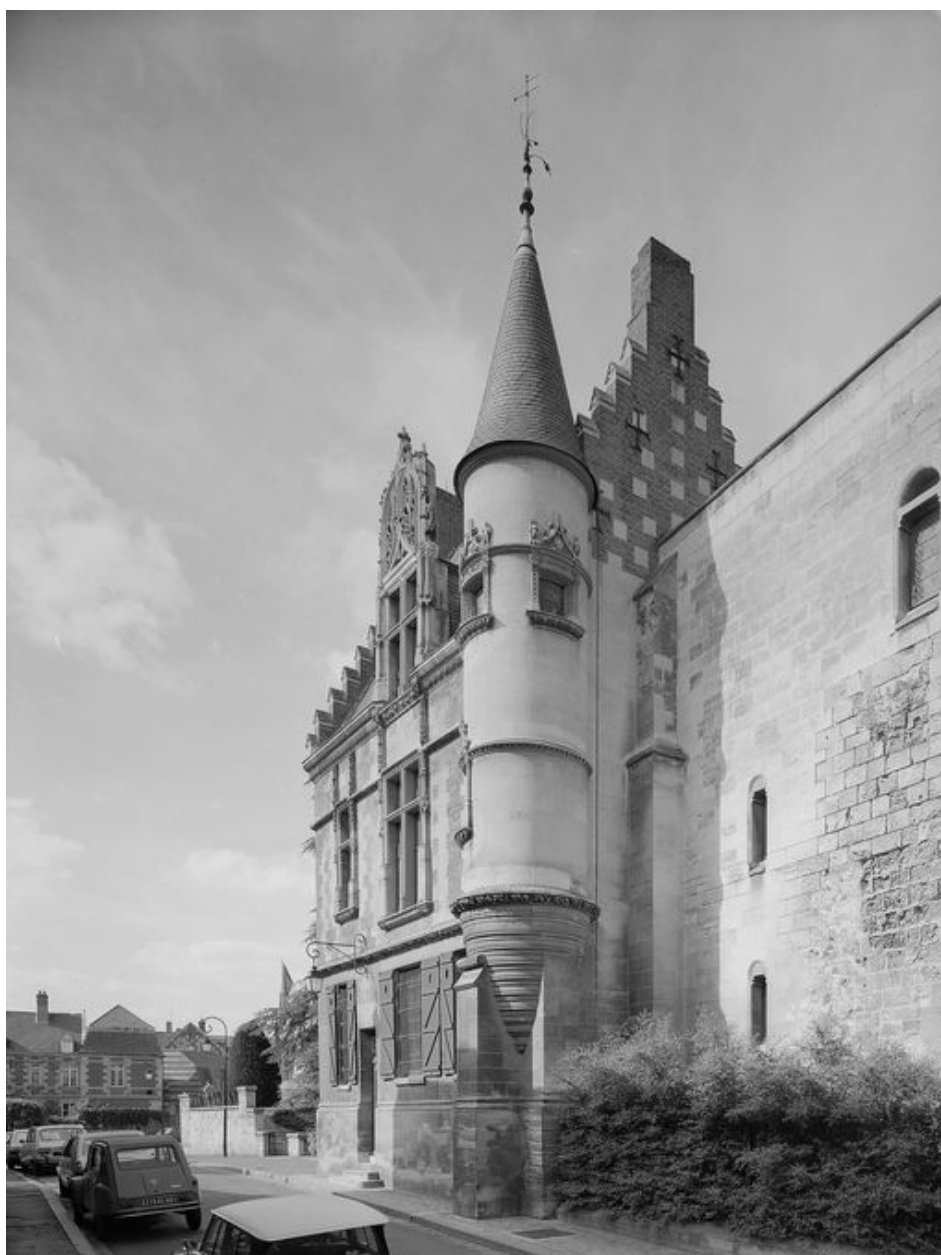
La tour Rolland et l'aile du 16e siècle (restaurées).
