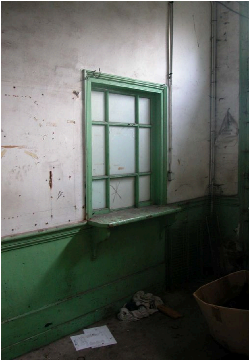
Détail du couloir d'entrée des ateliers de fabrication.
