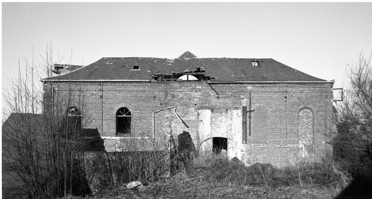
Elévation arrière de l'atelier de fabrication.
