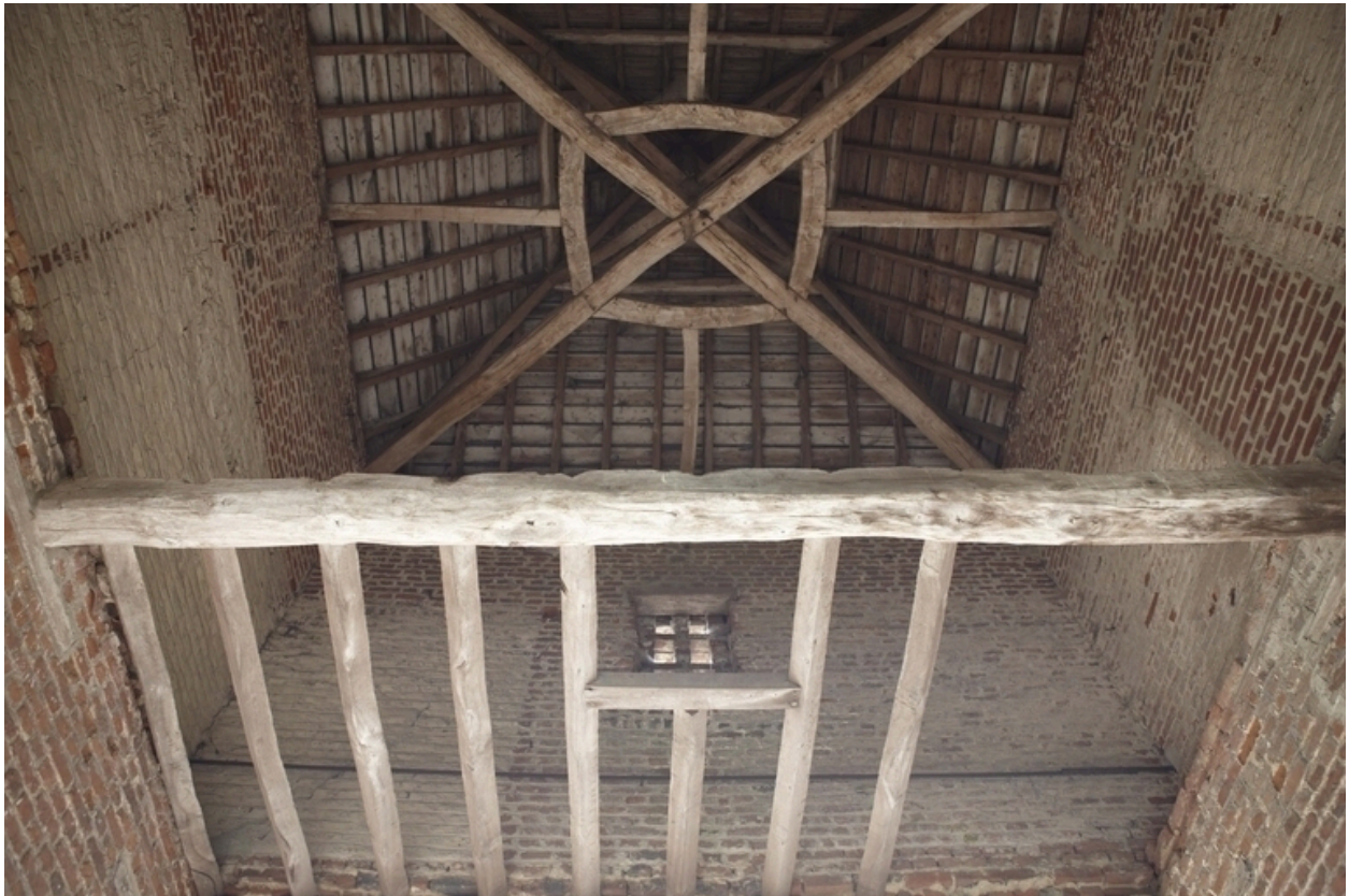
Détail de la voûte du pigeonnier-porche.
