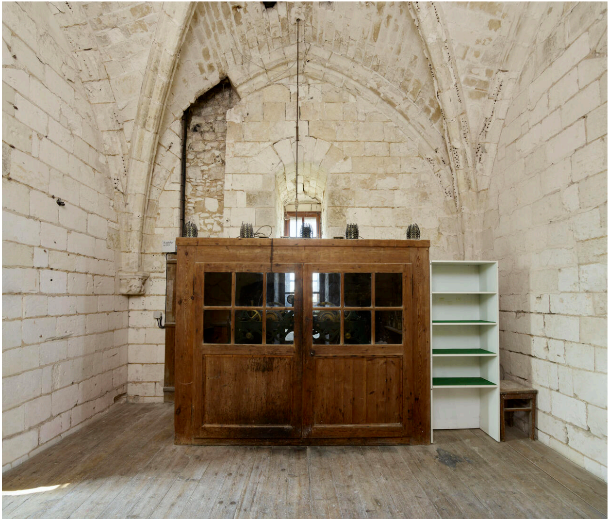
Armoire abritant le mécanisme des cloches du beffroi, dans la salle des gardes.
