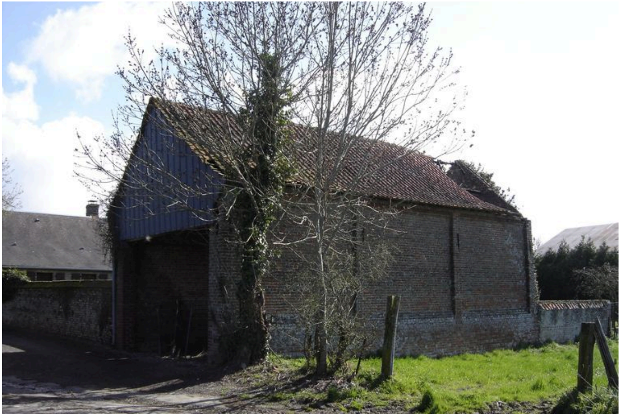
Vue du hangar en fond de parcelle.
