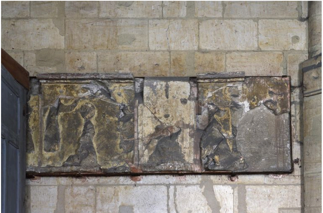
Vue partielle du 6e relief de l'ensemble.
