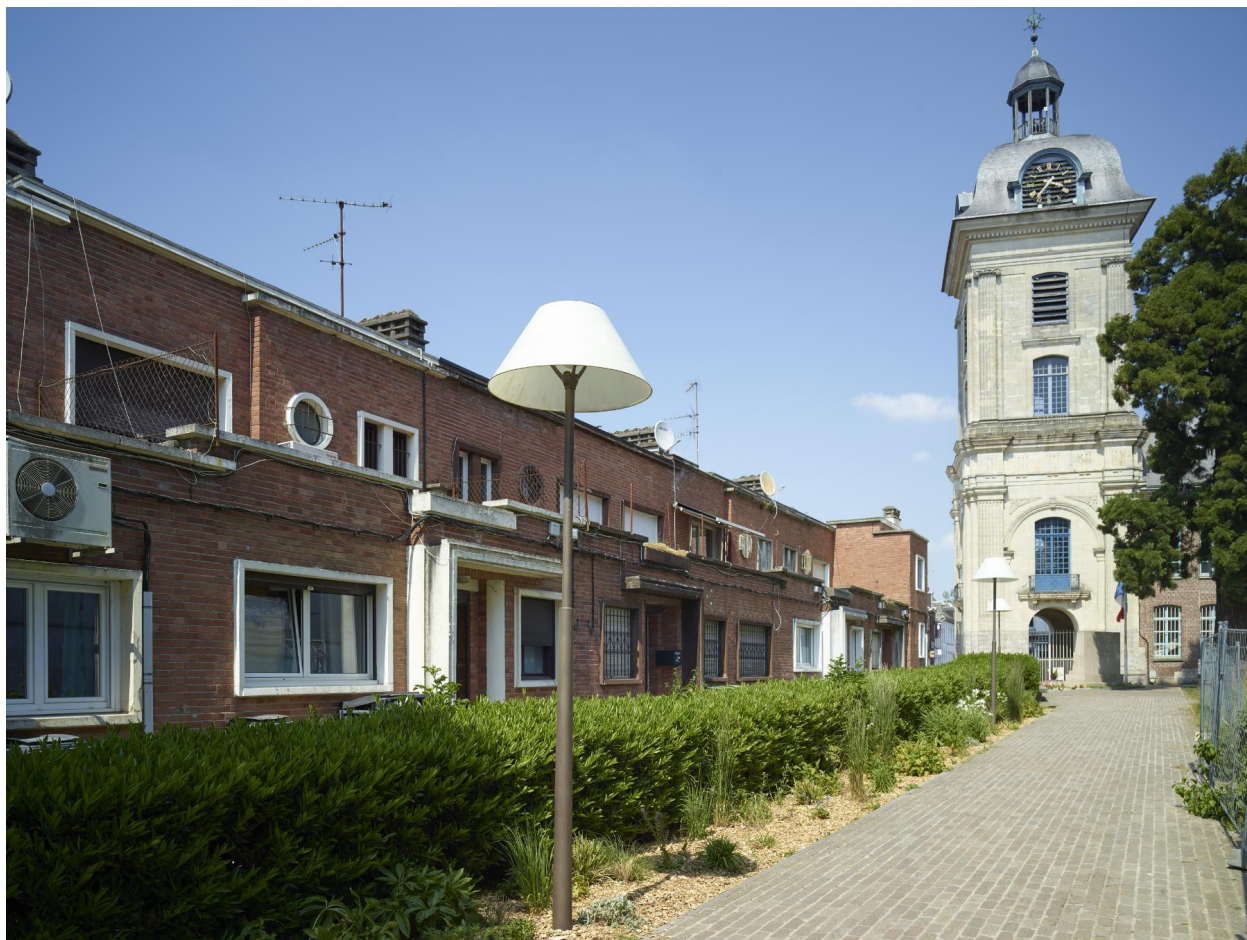
Vue générale des façades arrières orientée sud-ouest/nord-est.
