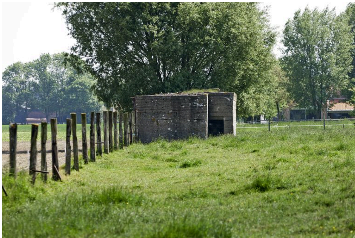
Vue vers le nord-est
