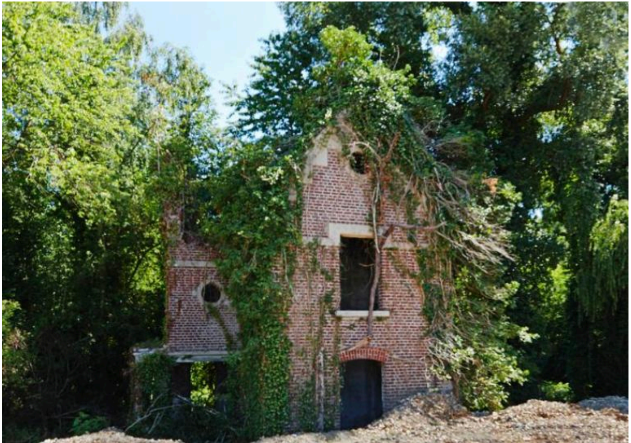
Ancienne maison de gardien de l'usine Kuhlmann.
