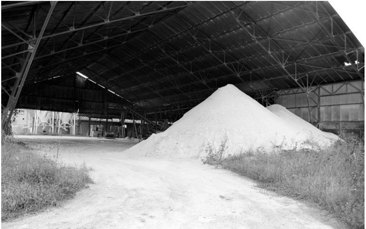
Hangar industriel destiné au stockage des matières premières (gypse).
