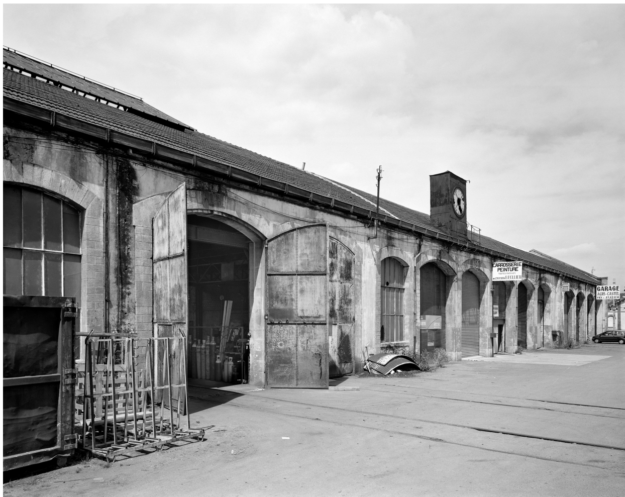
Entrepôts de réparation des locomotives : vue rapprochée.
