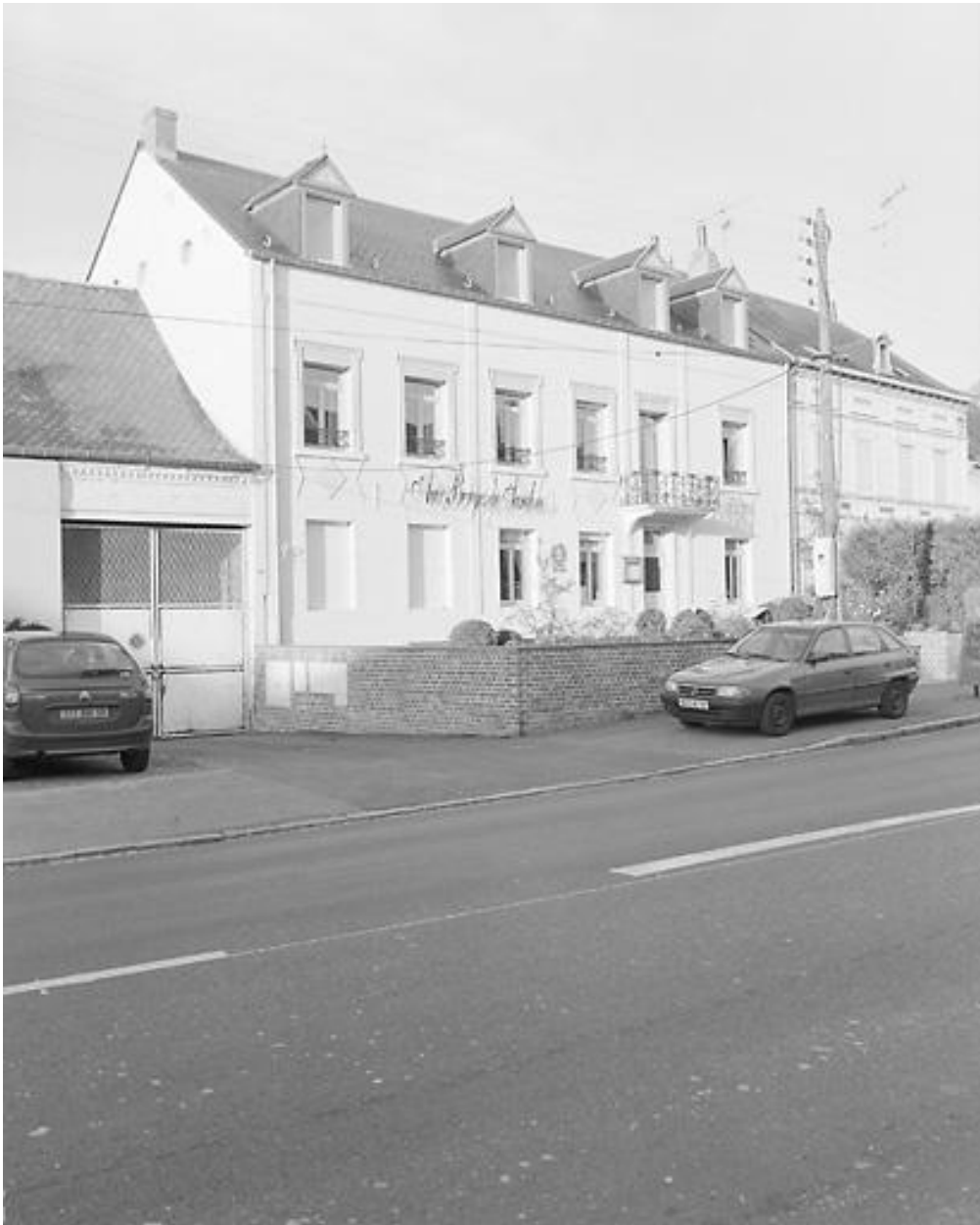
Élévation antérieure de la maison.
