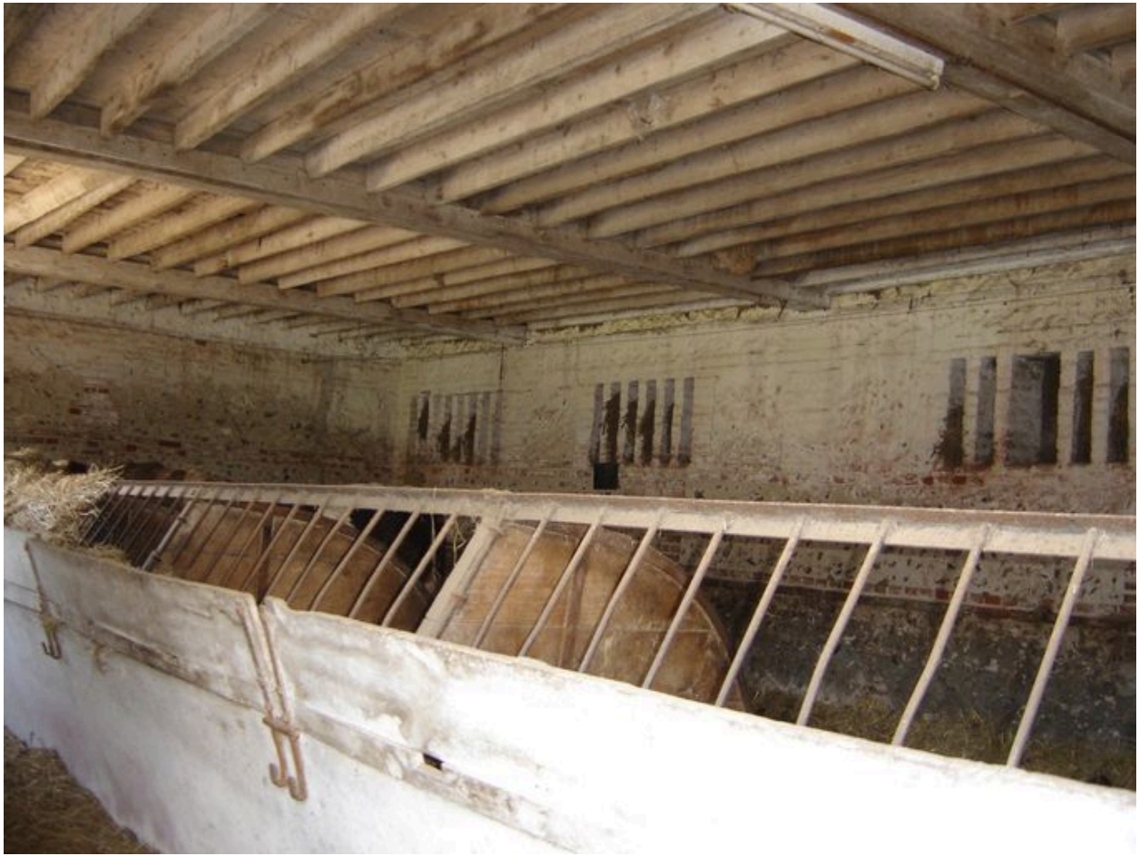
Vue intérieure d'un compartiment.
