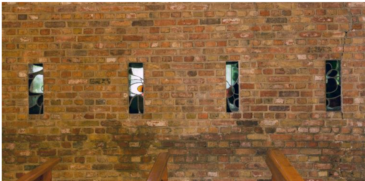
Vue des verrières côté droit.
