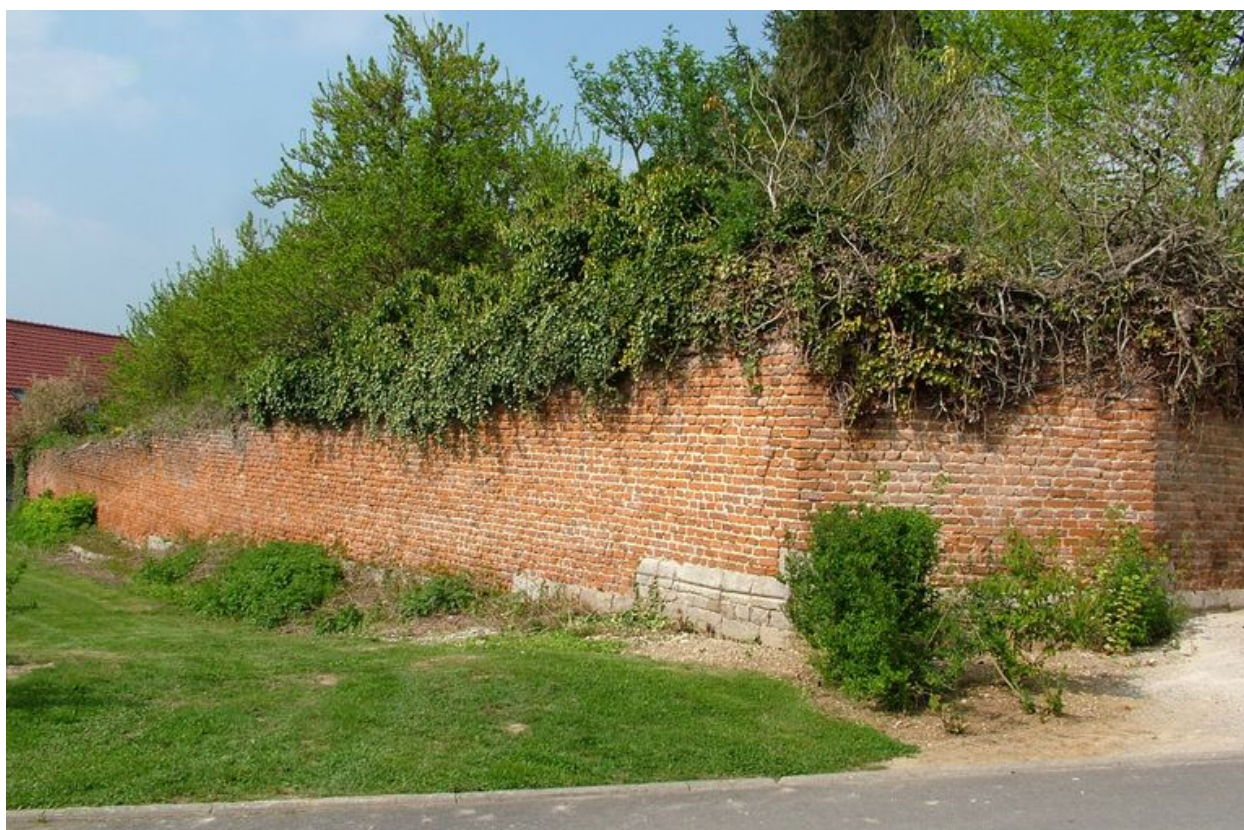
Mur de clôture.
