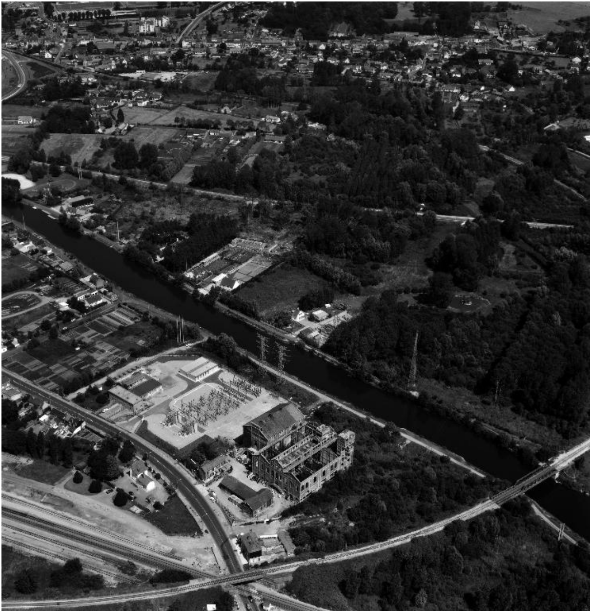
Vue aérienne de 1990, flanc sud-est.
