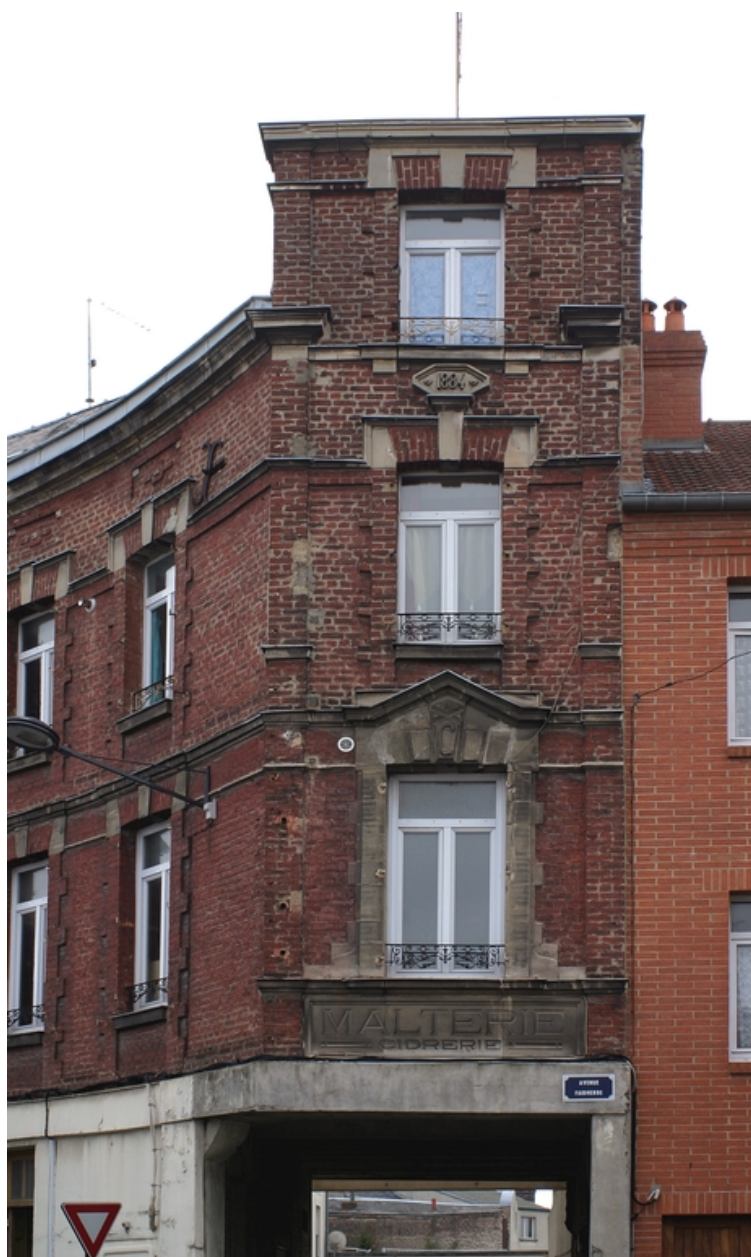
Façade antérieure des logements d'employés.
