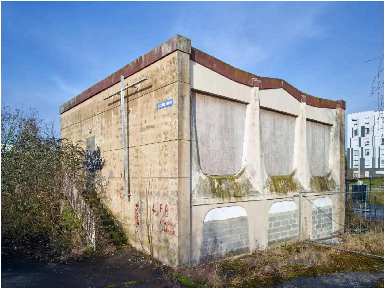
Élévation sud et ouest de l'édifice.
