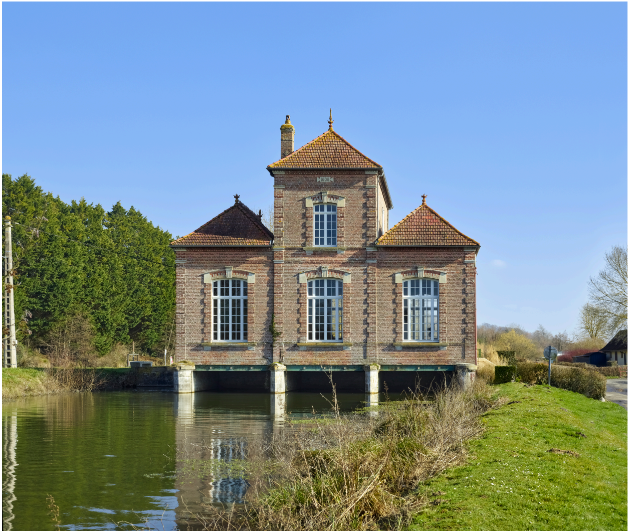
Vue de la façade est.
