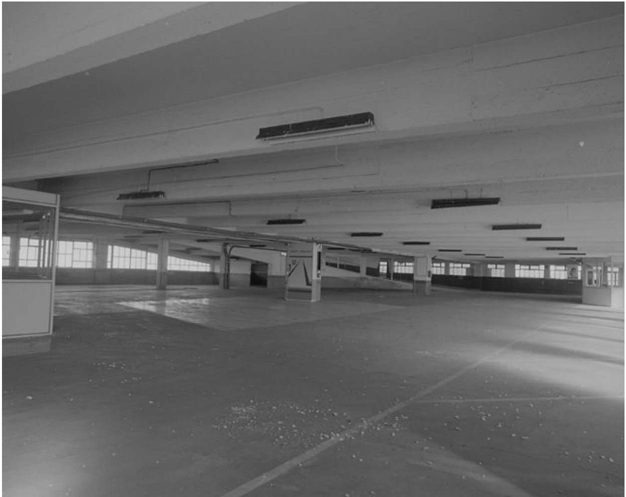
Vue d'ensemble du niveau 1.
