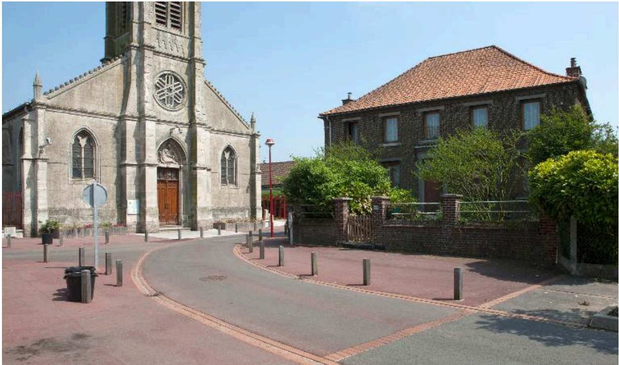
Vue générale de l'église et du presbytère.
