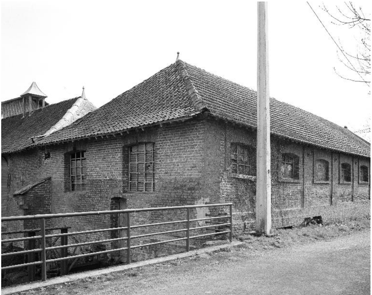
Atelier de fabrication, flanc ouest.
