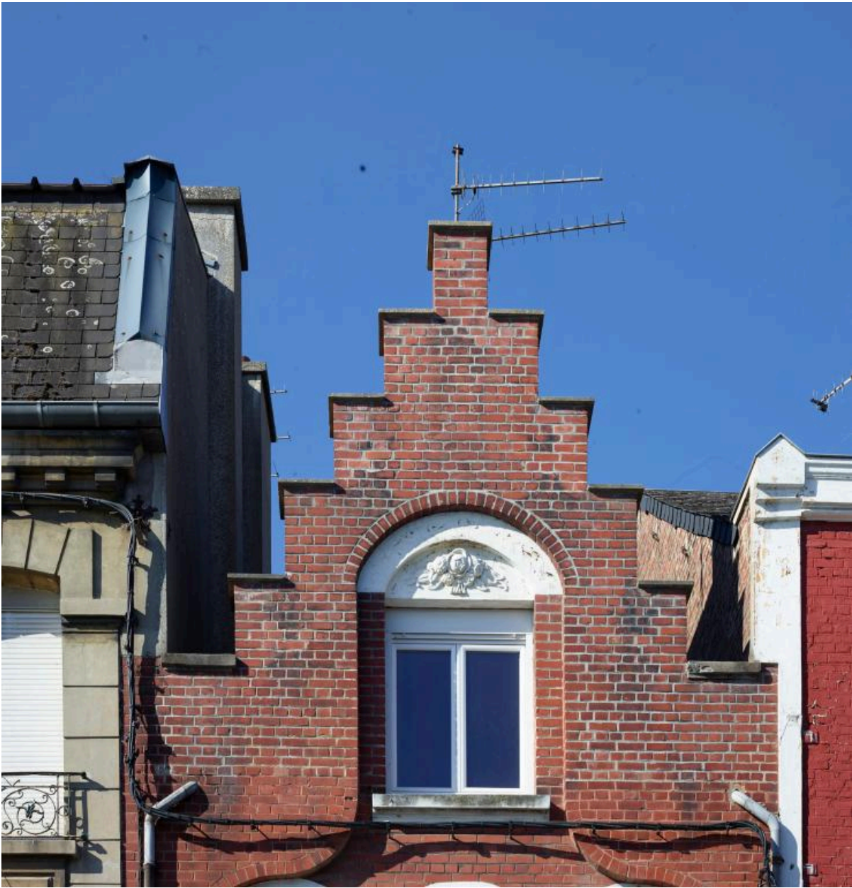
Détail du pignon à redents.
