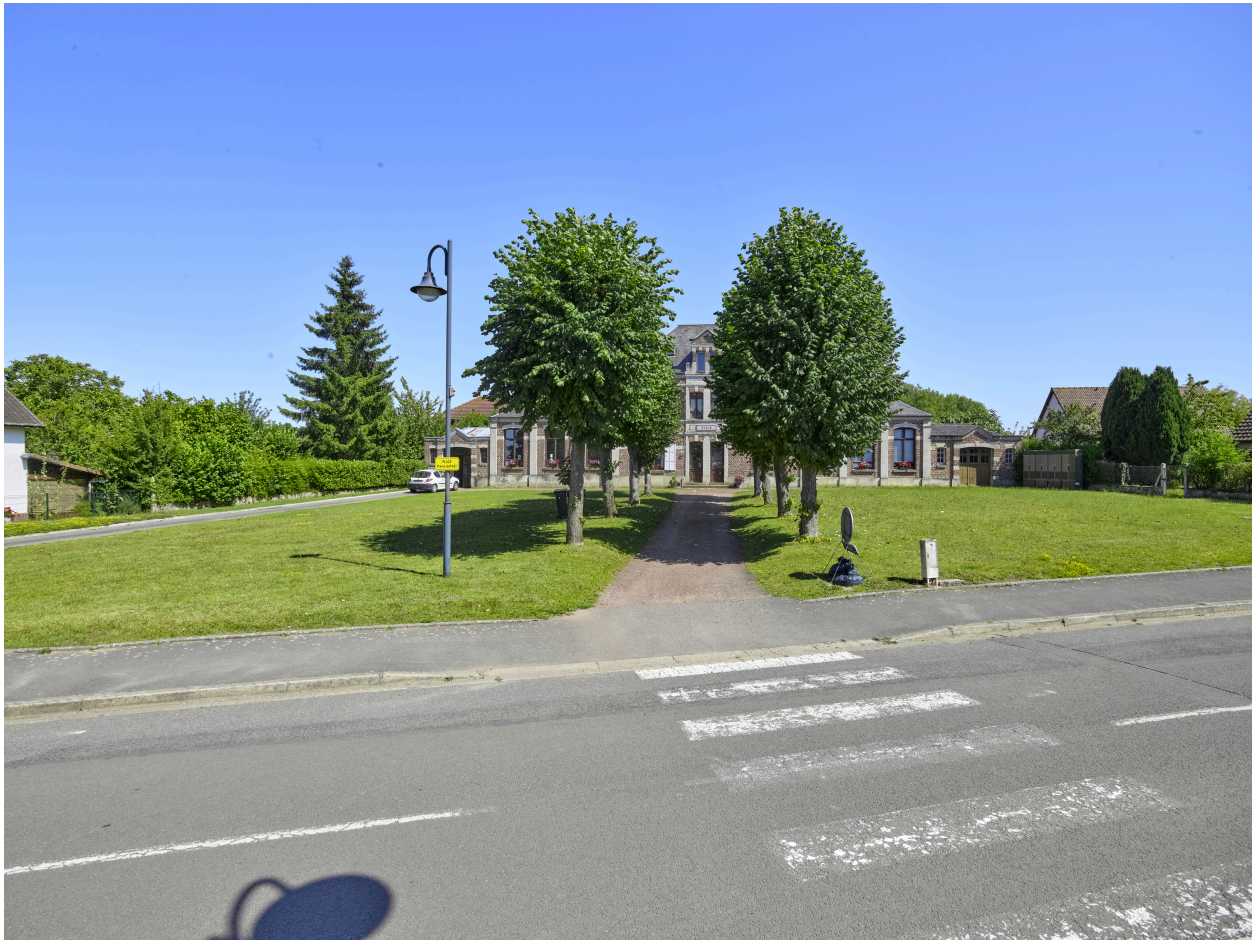
Vue du chemin d'accès à l'école, depuis l'ouest.
