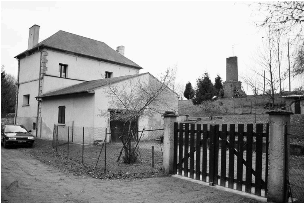
Logement patronal (1880) et vestiges de la cheminée de la féculerie.
