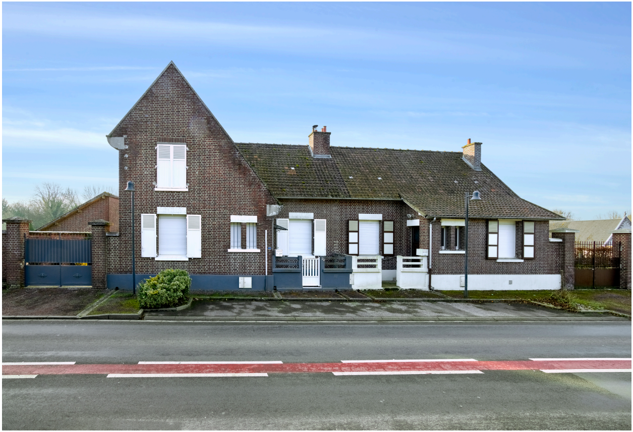
Vue de la maison, depuis le nord.
