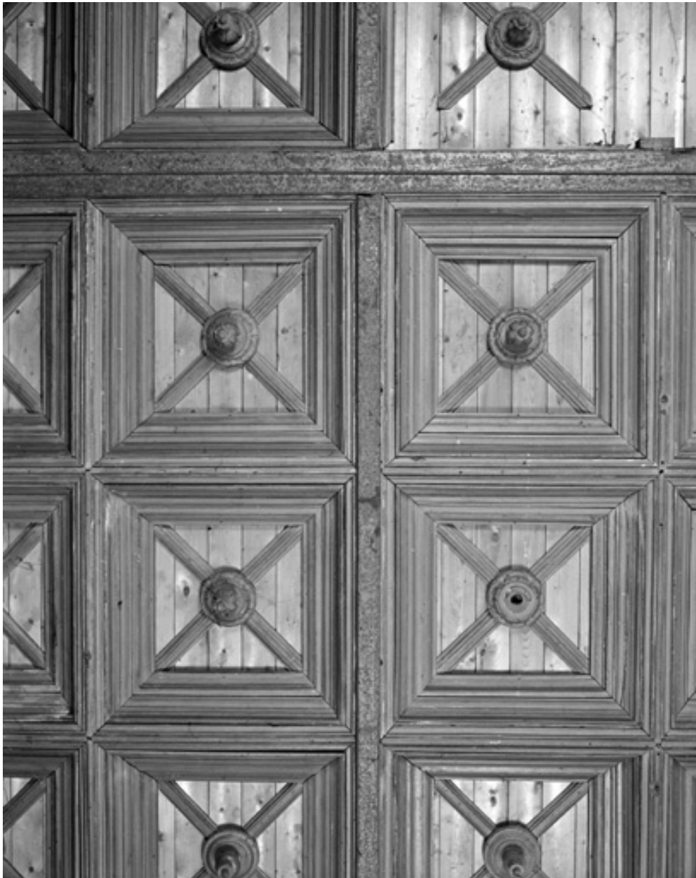
Plafond à caissons de la tribune d'orgue, refait au 19e siècle.
