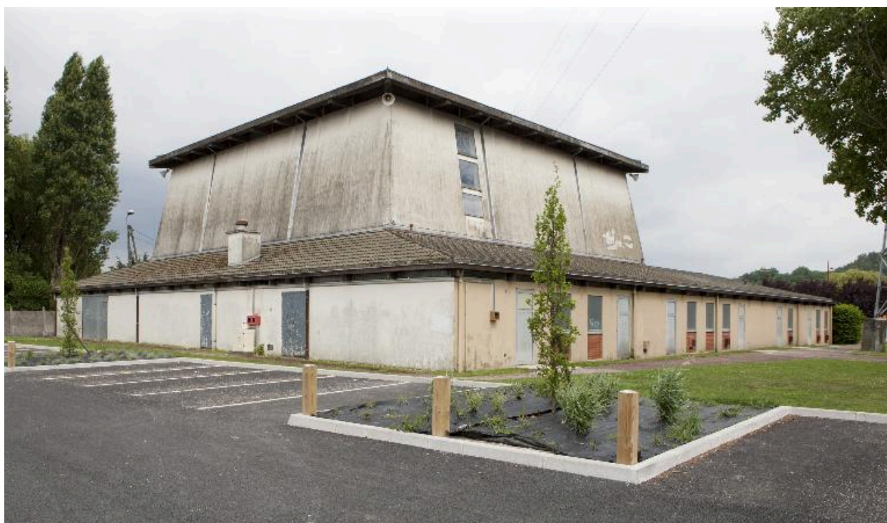
Vue de trois-quart, arrière gauche de l'église.
