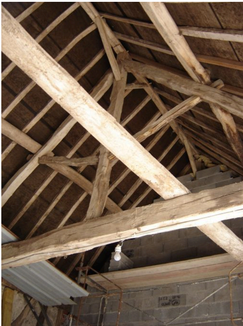
Vue détaillée de la charpente.
