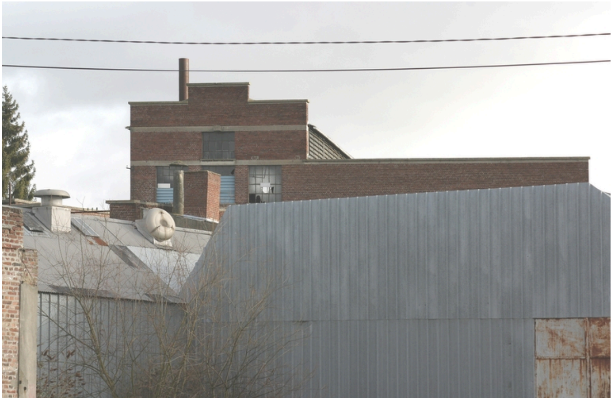
La centrale thermique, vue depuis la cour de l'usine.
