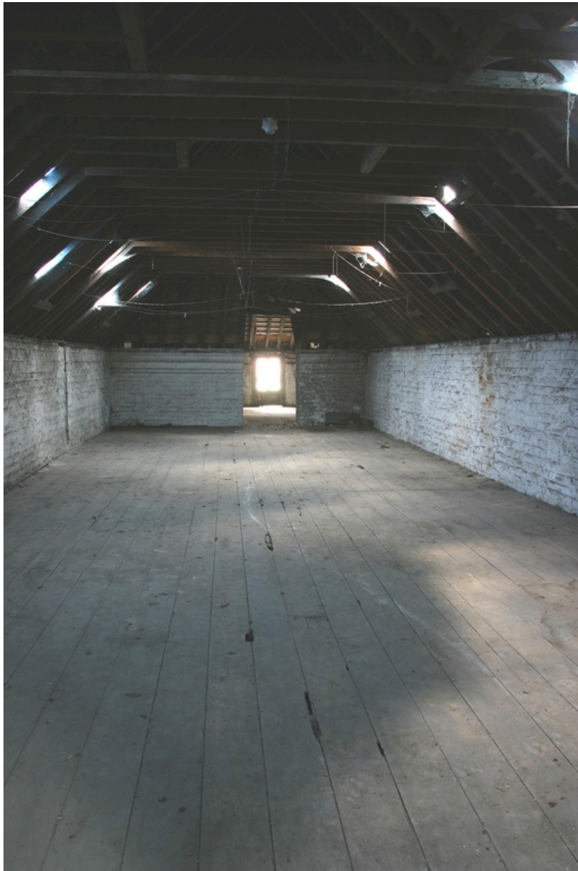
Combles des ateliers de 1870-1880 : ancien magasin industriel en 1914.
