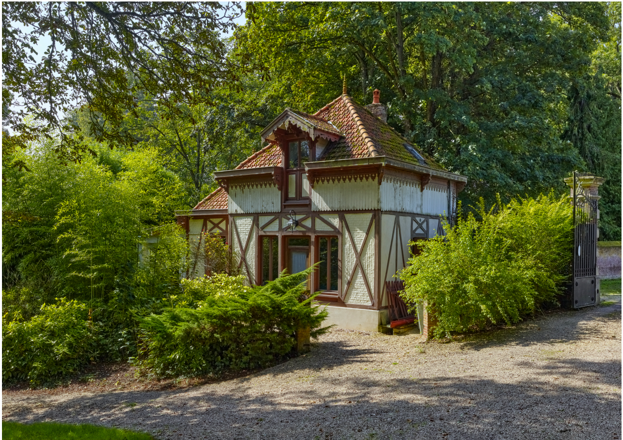
Vue de la maison du gardien, depuis l'est.
