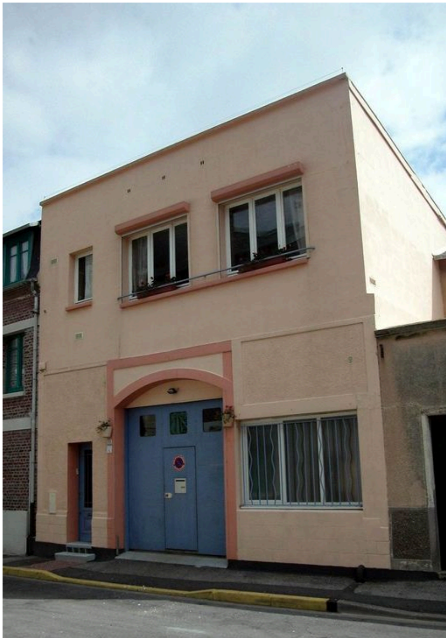
Maison, 13 rue Faidherbe.
