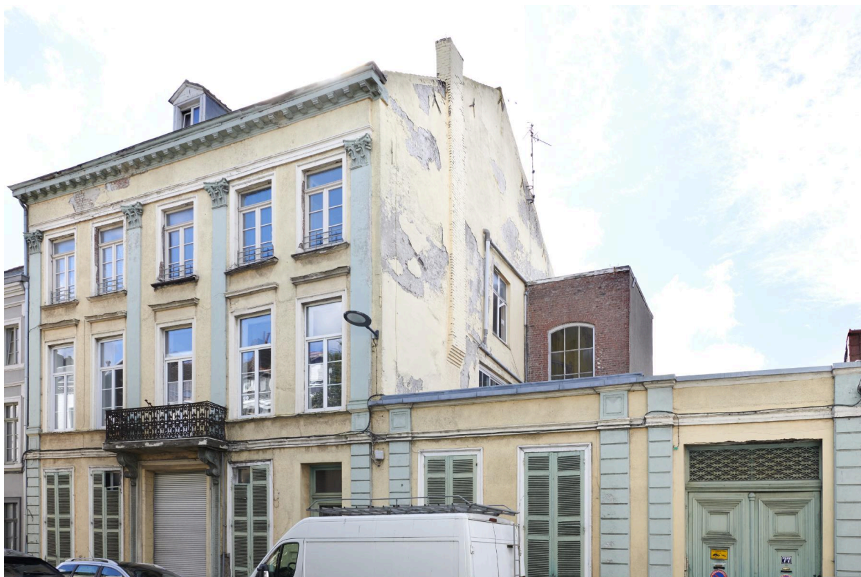
Vue générale de l'ensemble avec annexe.
