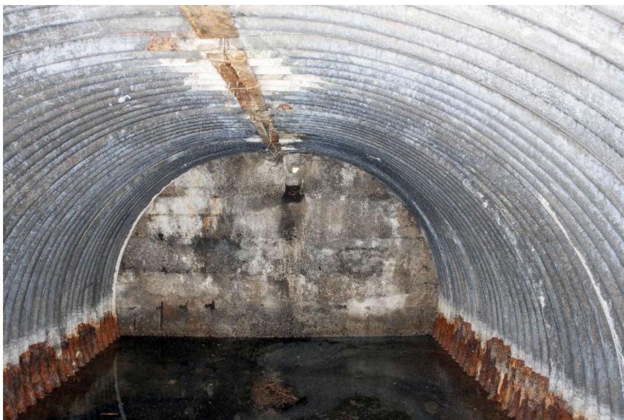
L'abri à personnel, depuis le couloir
