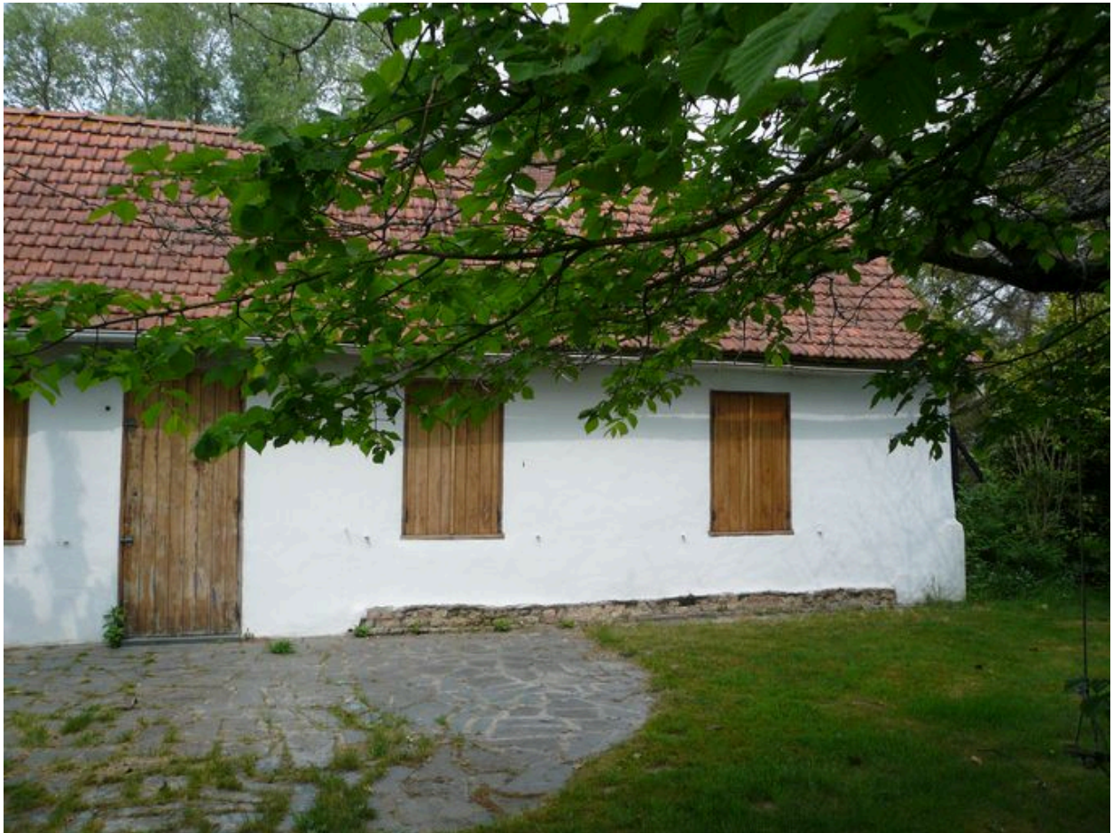
Vue d'une partie du logis.
