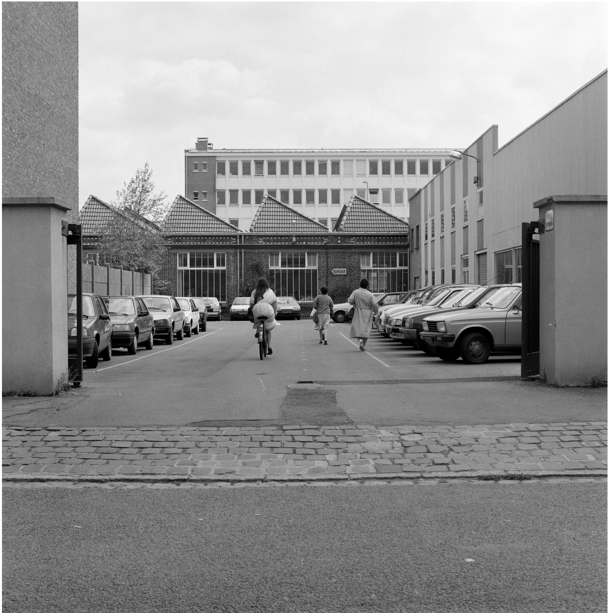
Atelier de fabrication. Vue prise vers l'est.
