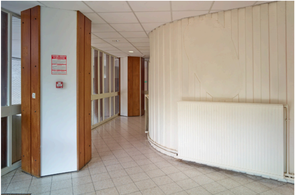
Vue des poteaux de forme hexagonale et du noyau central contenant les circulations de la tour de l'internat, depuis le niveau de la plate-forme.
