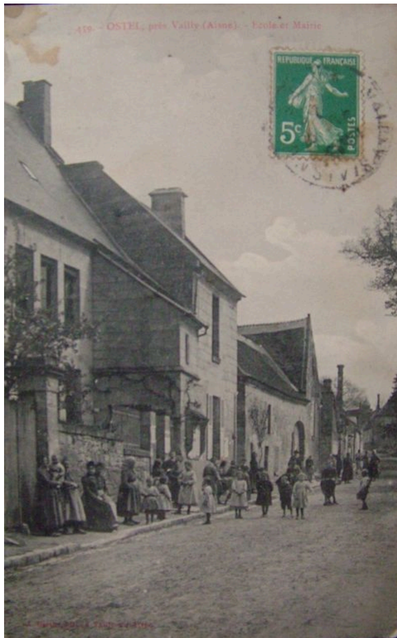
Vue de l'ancien édifice (coll. part).
