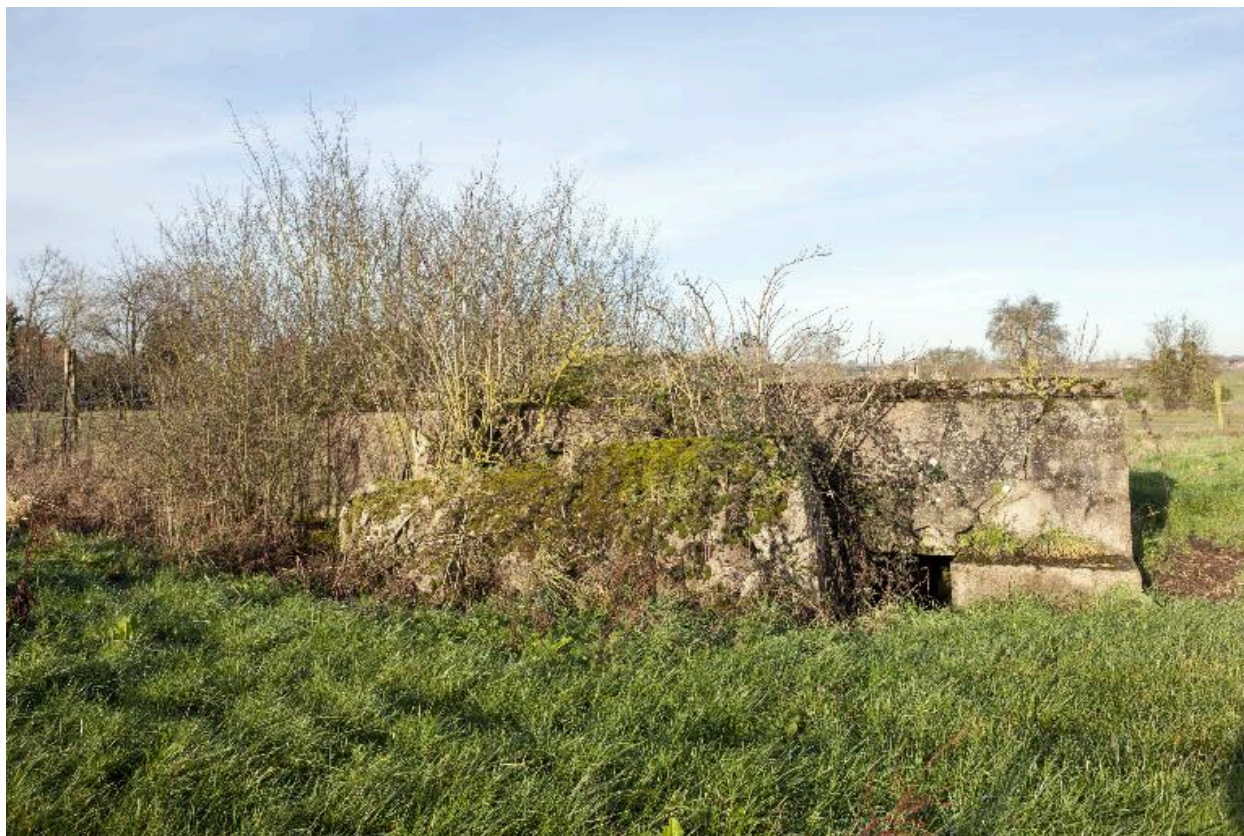
Casemate A : Vue générale vers l'ouest, entrée nord
