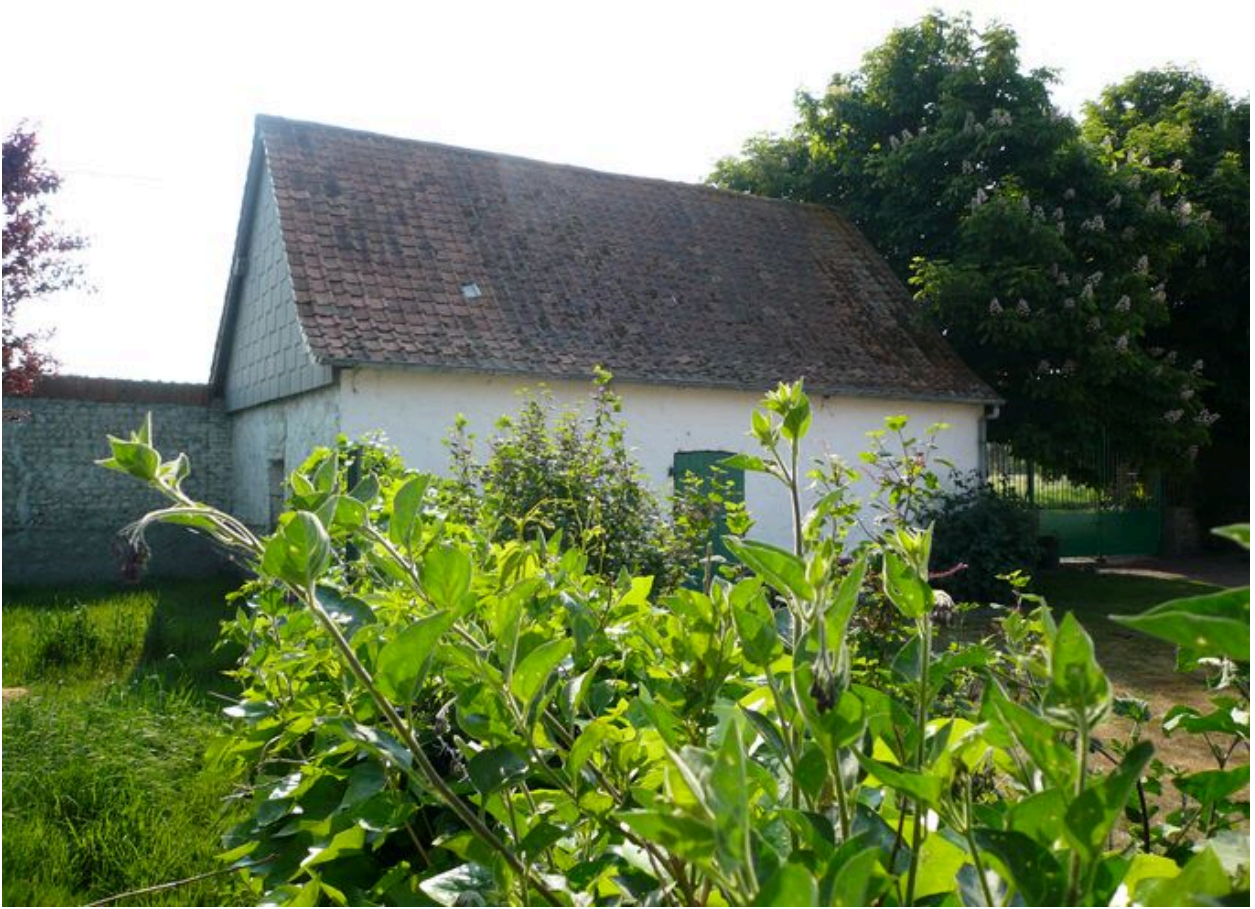
Vue des étables depuis la cour.
