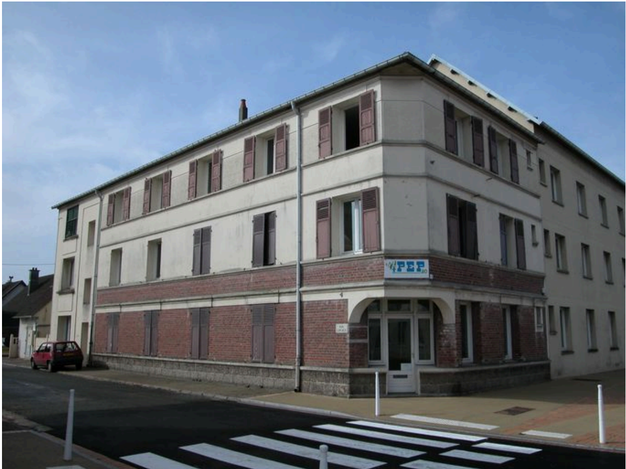
Vue d'ensemble du corps de bâtiment le plus ancien.
