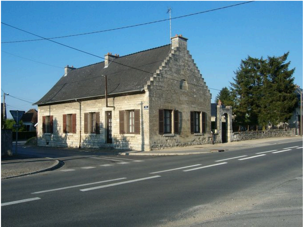
Vue du mur-pignon.
