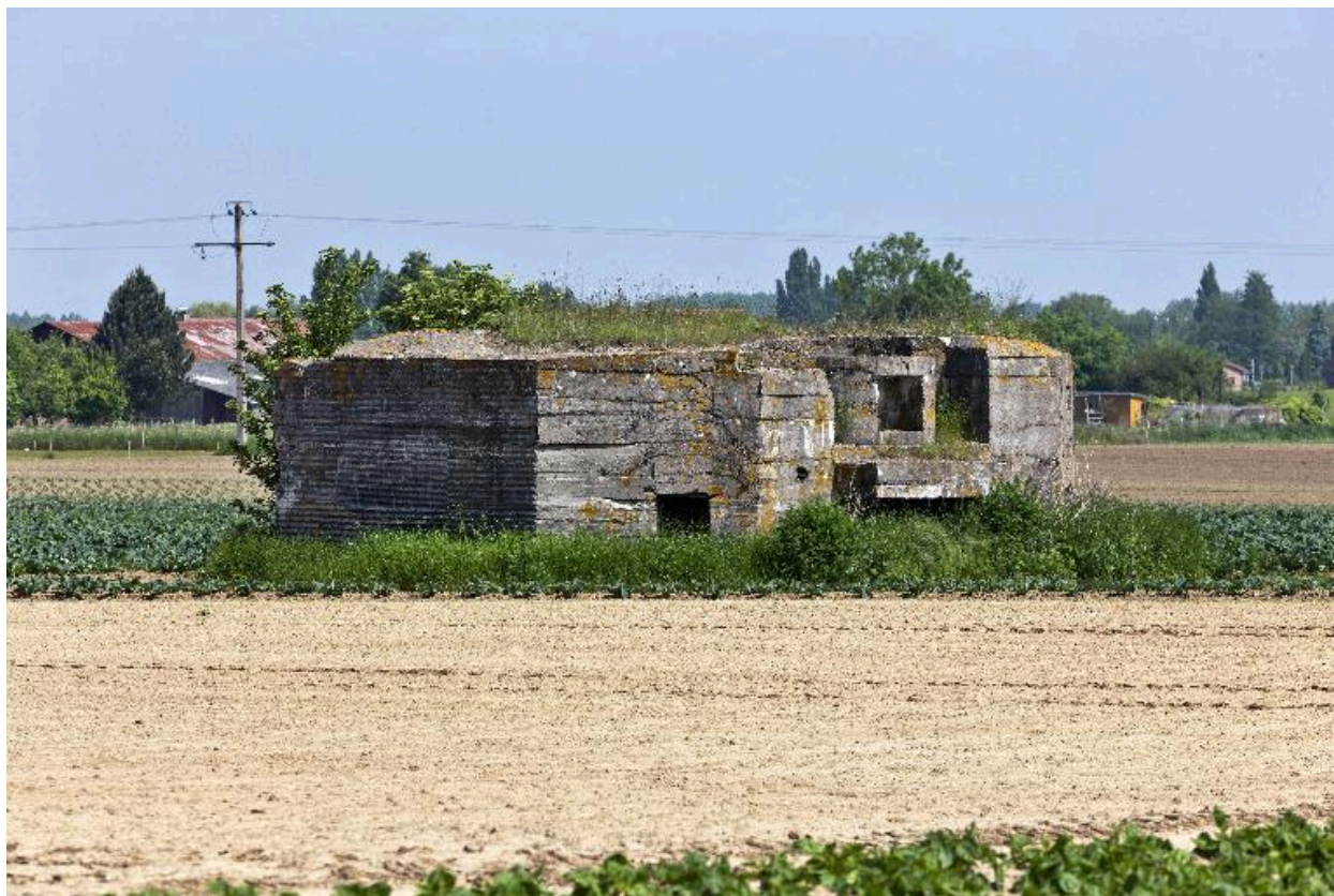
Vue de trois-quarts, vers le nord. Entrée sud-est
