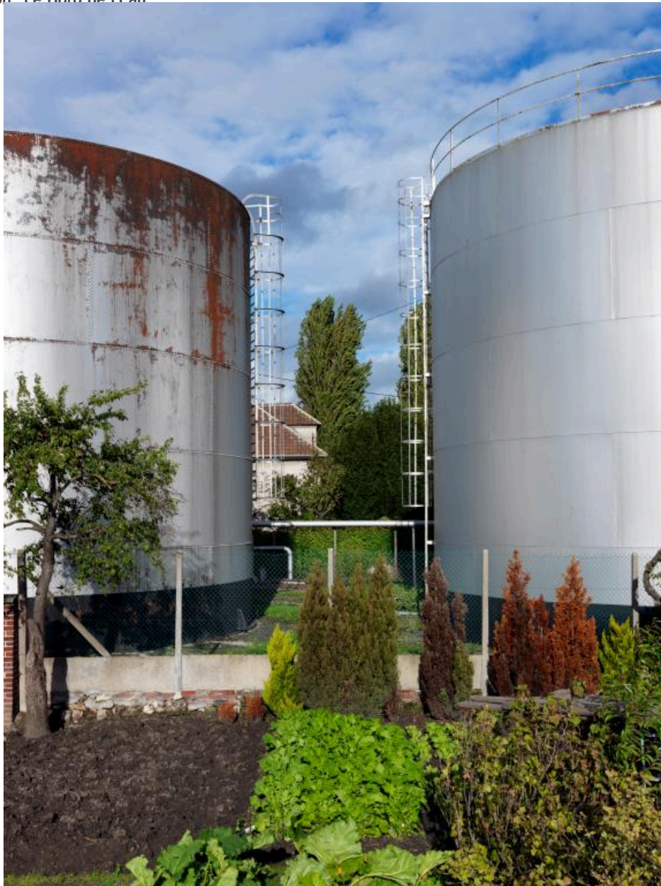
Ancienne scierie Delaplace, puis entrepôts de mélasse Fina : échelle de visite des cuves à mélasse de betteraves vue depuis le sud
