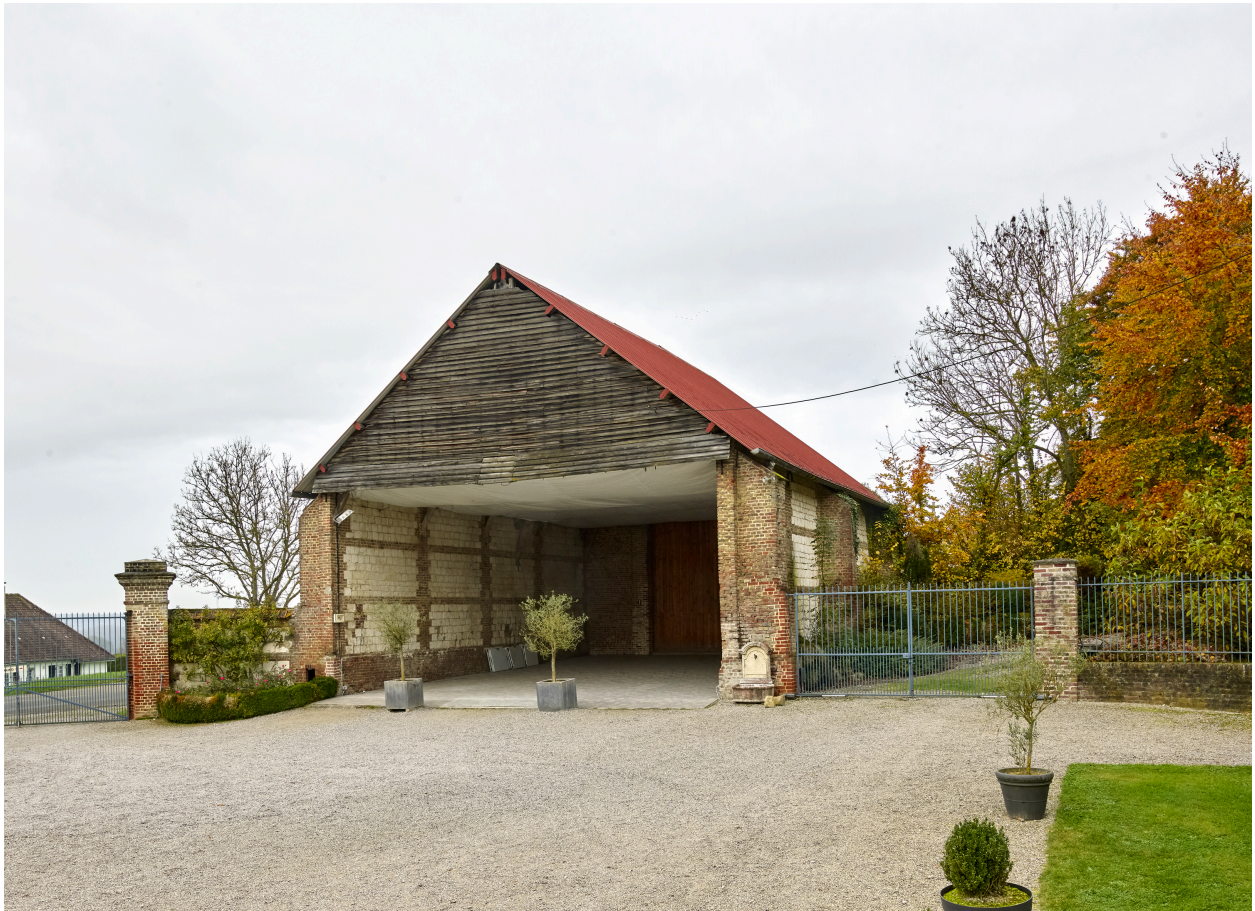
Vue du hangar nord, depuis l'est.
