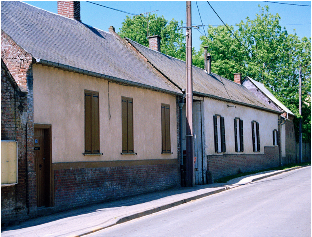
Elévation sur rue du logis.
